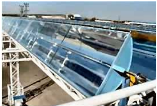
Sopra un esempio di concentratori solari termici installati su di una struttura rialzata (Foto www.Baxterenergy.com ).
